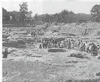
▲発掘された駿府今川館跡の一部
