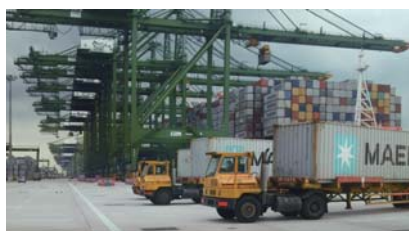
シンガポール港コンテナターミナル
