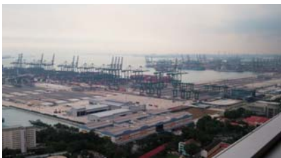
PSAビルよりシンガポール港湾施設を望む
