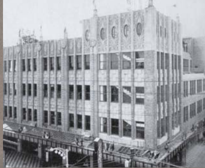
昭和8年に再建復興した田中屋の増築工事が、昭和13年7月に完成。売場面積5,000㎡。
