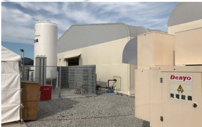
日建リース工業(株)の陸上養殖施設
