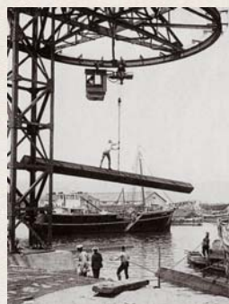
清水港テルファーによる 木材の積込み作業
